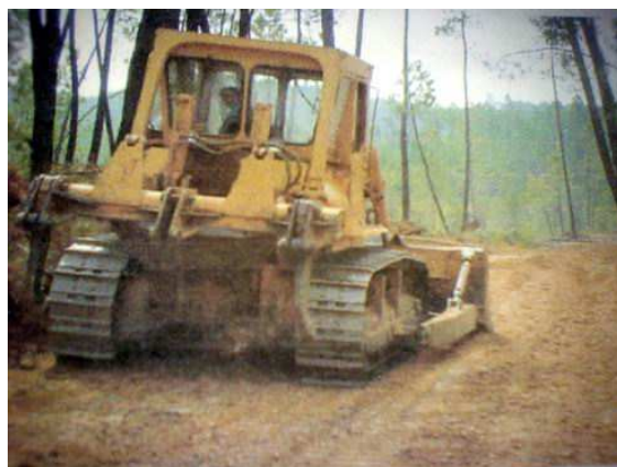
obrázek č.5 stavební stroj vytváří síť lesních komunikací
