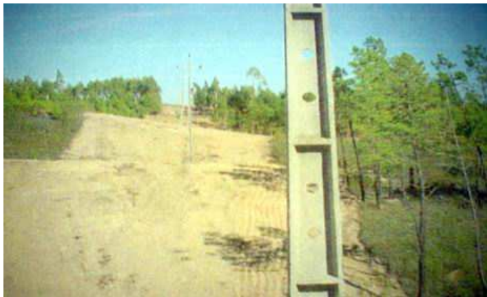
obrázek č.6 bezpečnostní pás v linii elektrického vedení
