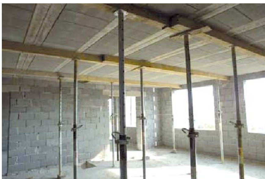
Obr. 79 Ilustrační foto podpěry stropu
