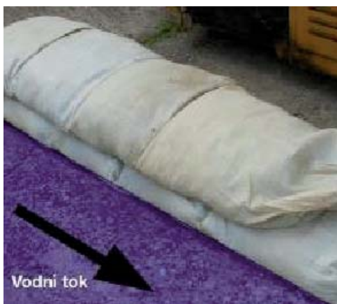
Obr. 7, 8 Způsob kladení jednokomorových pytlů (podélně, schématicky)
