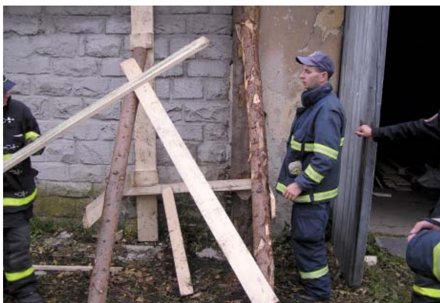
Obr. 80 - 82 Ilustrační foto z nácviku zajišťování narušených konstrukcí
