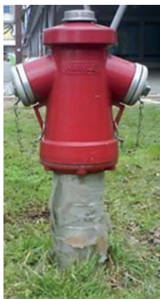
Obrázky č. 39, 40, 41 Různé typy nadzemních hydrantů
