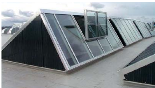
Obrázky č. 53 a), b) Zařízení pro odvod kouře a tepla
