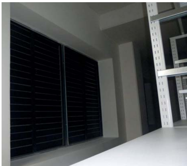
Obrázek č. 31 Přetlakové klapky nainstalované v prostoru chráněném GHZ (archiv NK Praha-Hostivař)
