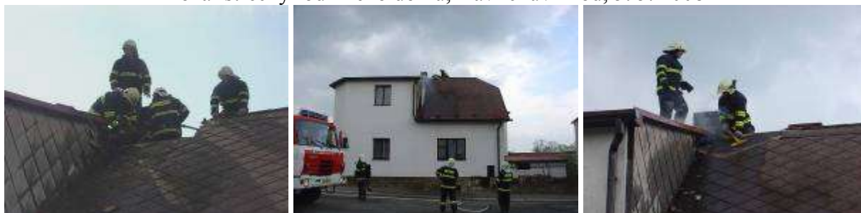
Požár střechy rodinného domu, Havlíčkův Brod, 5. 5. 2008
