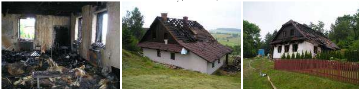
Požár novostavby, Karasín, 7. 6. 2008
