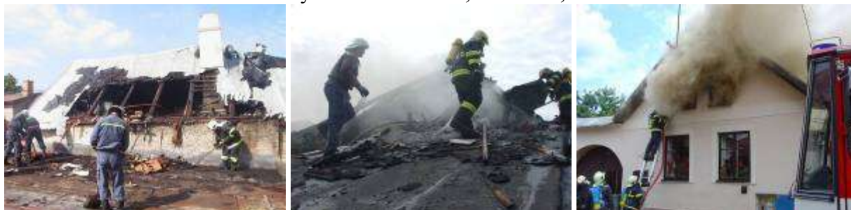
Požár střechy rodinného domu, Chotěboř, 26. 7. 2008
