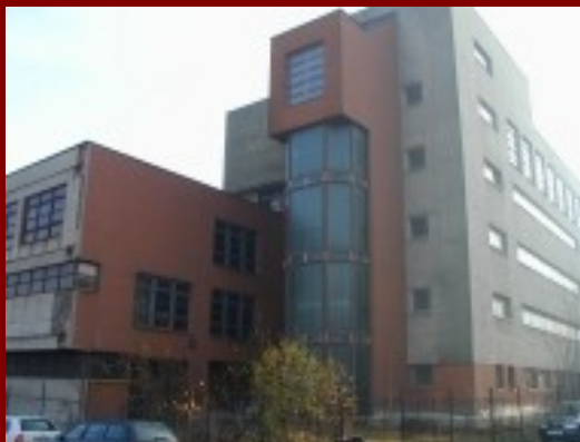
Pohled od ul. Nemocniční ...
