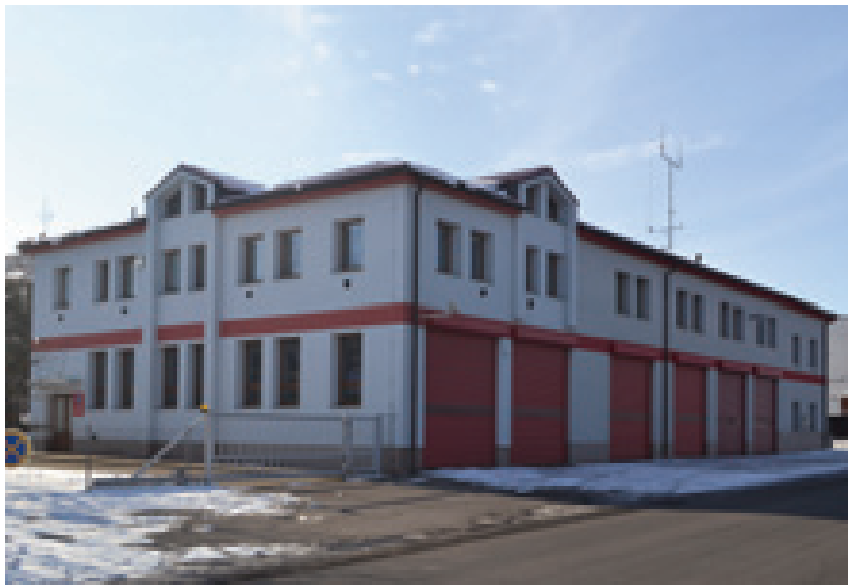
Současný vzhled chotěbořské požární stanice
