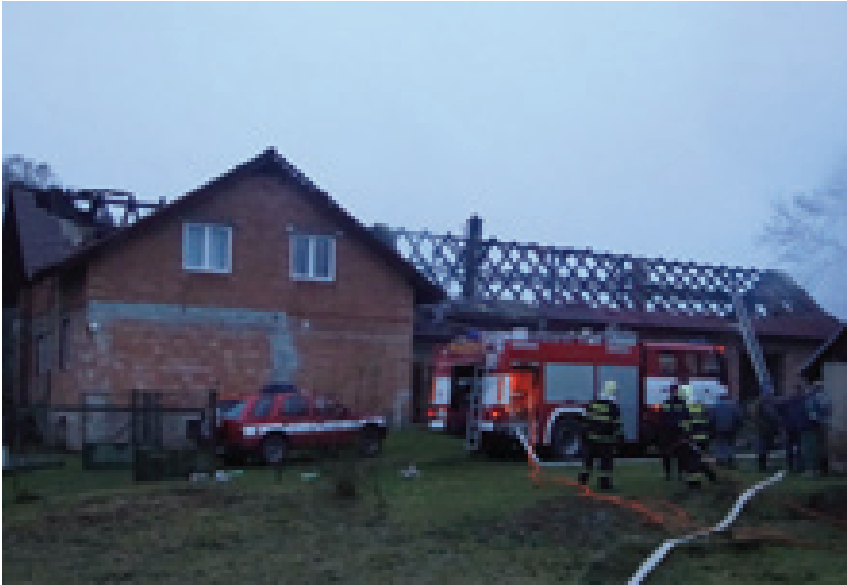
2009 – požár rodinného domu ve Vepřikově
