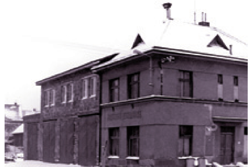
Hrubá stavba požární stanice byla hotova v roce 1978
