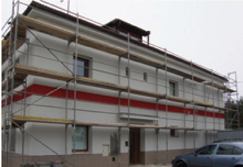
Novou fasádu a střechu získala stanice v roce 2012
