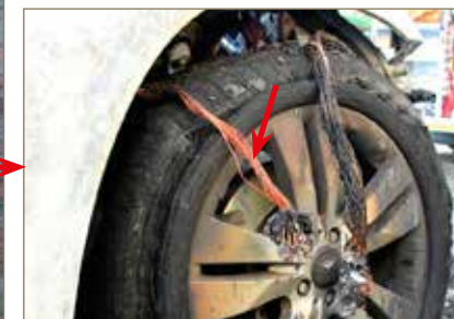
Obr. č. 4: Pohled na elektroinstalaci, která byla podrobena zkoumání.
