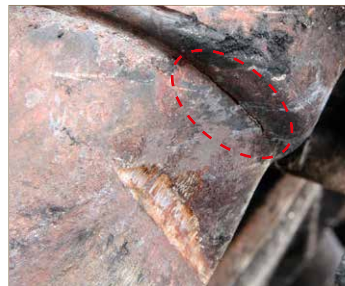
Obr. č. 4: Detailní pohled na prasklinu znatelnou na spojení filtru pevných částic s výfukovým vedením.
