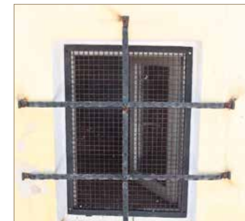
Obr. č. 10: Účinky blesku na uchycení mříže.
