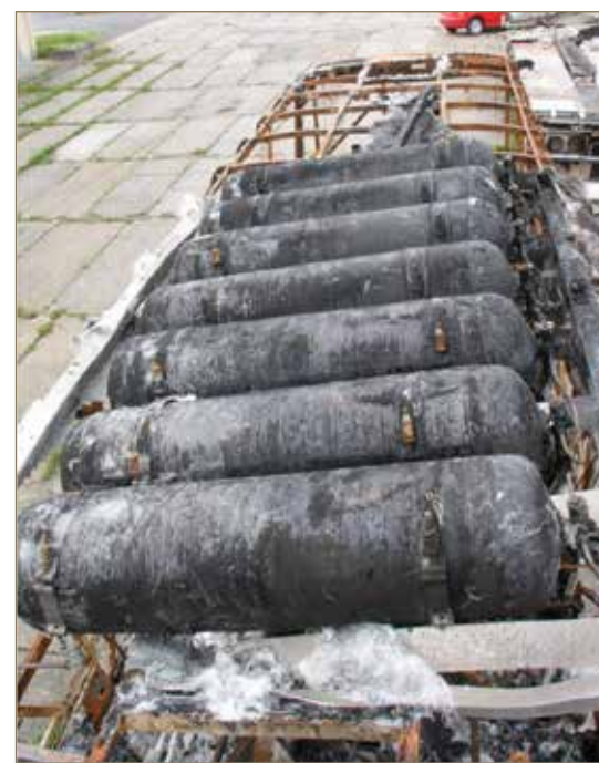
Obr. č. 3: Umístění tlakových nádob na střeše autobusu a jejich stav po požáru.
