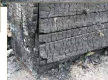
Obr. č. 3: Pohled na ohniskové příznaky.
