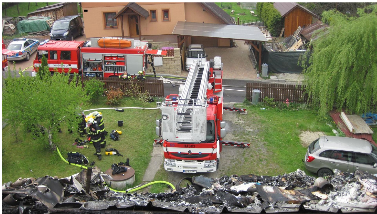
Pohled na místo mimořádné události – požár střechy a půdních prostor rodinného domu (Hasičský záchranný sbor Zlínského kraje)
