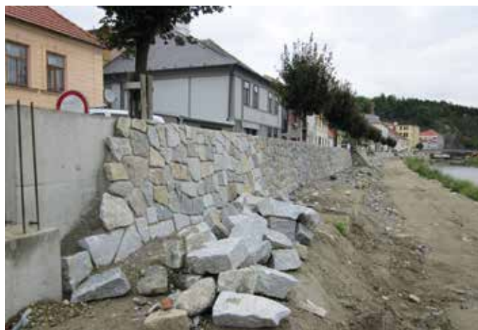
Zvýšení kapacity koryta řeky v Třebíči.
