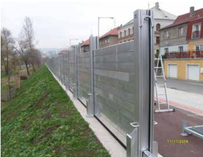
Labe - PPO Ústí nad Labem-Střekov (mobilní bariéra).
