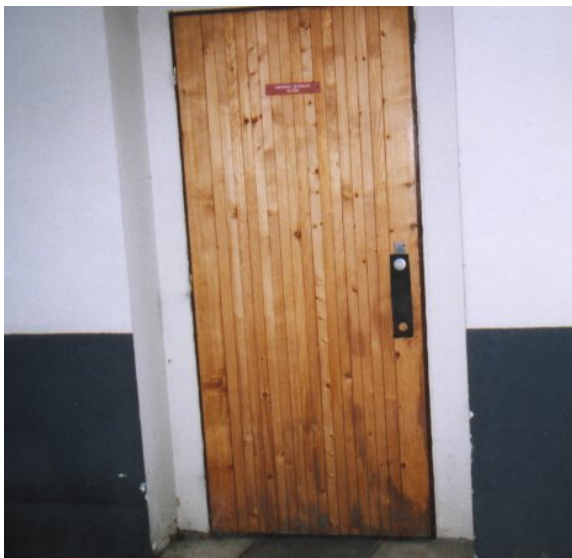
Obrázek č. 20a System značení pomocí pryžových štítků. Jednoduché převlečení přes kliku - tým je uvnitř.
