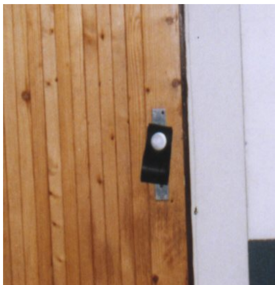
Obrázek č. 20b Po převlečení spodní části pryžového štítku je dalším hasičům zřejmé, že pátrání uvnitř je kompletní.
