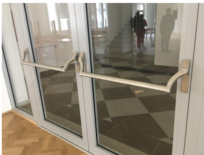
obr. č. 4 a 5 příklady a použití panikového madla
