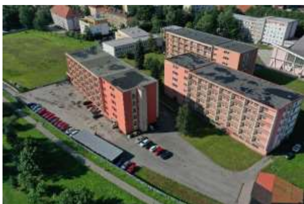
Obrázek č. 1: Areál na ulici Pionýrů
