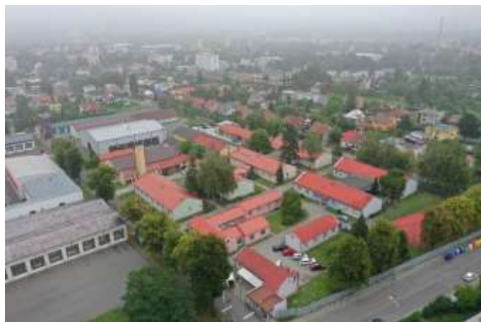
Obrázek č. 17: Celkový pohled na areál na ulici Pavlíkova
