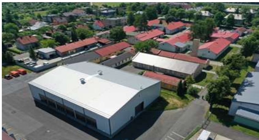
Obrázek č. 18: Výcviková multifunkční hala
