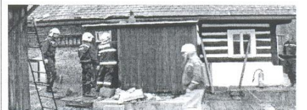
VČASNÝ ZÁSAH. Ve Vestci na Náchodsku začal v úterý hořet dřevěný přístavek rodinného domu. Požár zasáhl plochu zhruba 2x3 metry a způsobil škodu za tisíc korun. Včasným zásahem hasičů z Jaroměře a Českého Skalce se podařilo zabránit rozšíření ohně na obytný dům. Foto: HZS Královéhradeckého kraje
