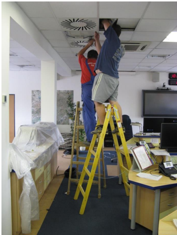
Montáž osvětlení sálu
