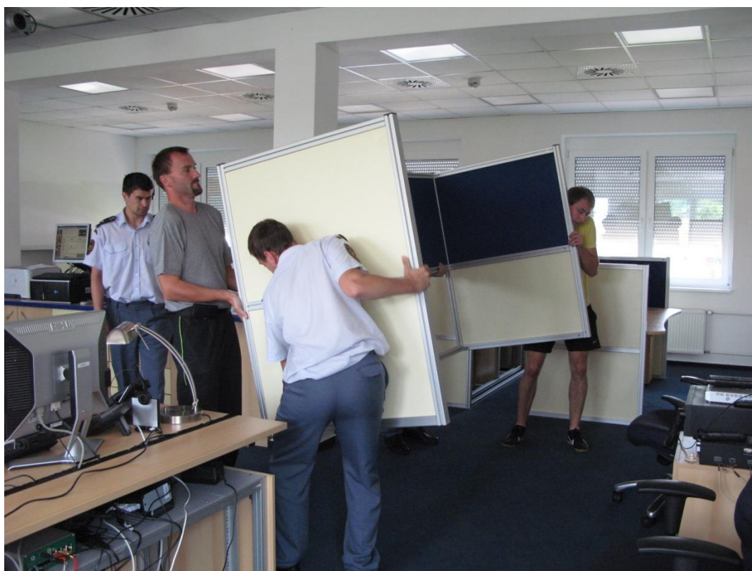
Montáž protihlukových zábran
