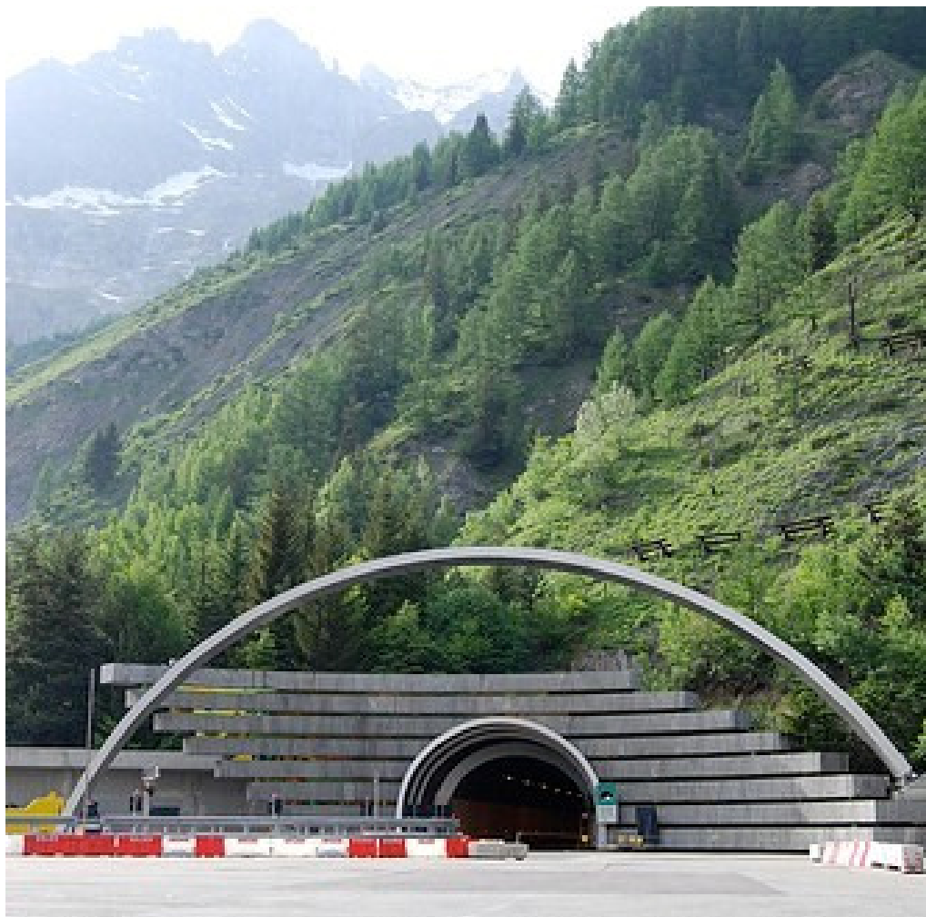
Obrázek 7 Silniční tunel Mont Blanc (11,6 km) [13]
