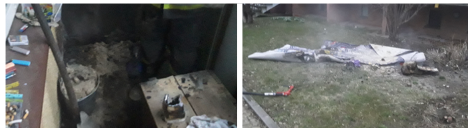
Požár na balkóně panelového domu v Šumperku z března 2021.
