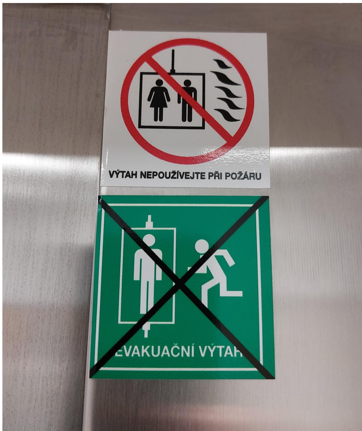
Foto 16 – Bezpečnostní značení na výtahu: Nepoužívat jako evakuační výtah
