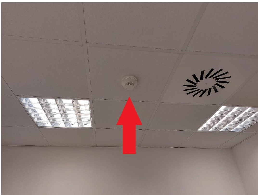
Foto 8 - Umístění detektoru kouře na stropě
