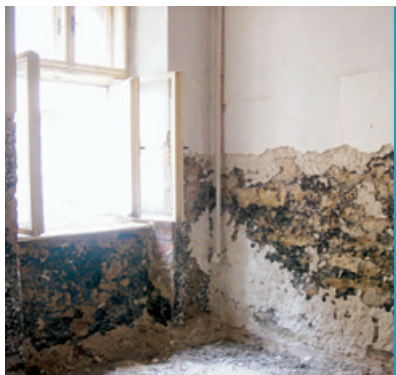
Vnitřní izolace (na bázi asfaltu a téru).
