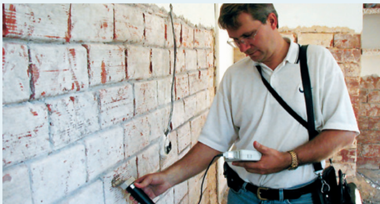
Objektivní posouzení stavu zdiva vyžaduje kvalitní měřicí přístroje.
