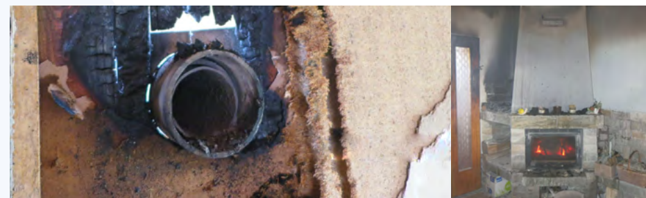
Důsledek špatné instalace topidel a kouřovodů
