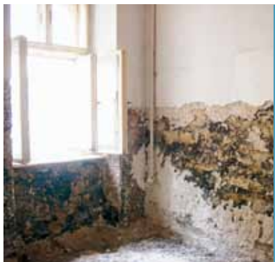
Vnitřní izolace (na bázi asfaltu a téru).
