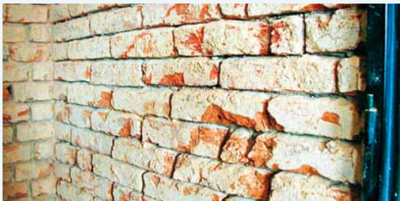
Dobře připravené zdivo
