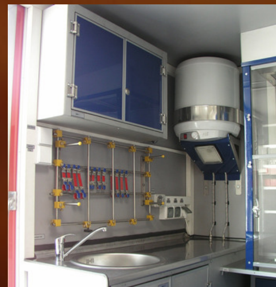
Výjezdové vozidlo chemické laboratoře Tišnov
