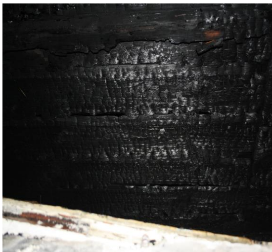
Obr. č. 4 a 5 Poškození požárem v meziprostoru střešní konstrukce a stěny kuchyně
