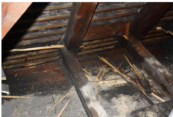
Obr. č. 3 Půdní prostor zasažený požárem
