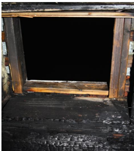
Obr. č. 4 a 5 Poškození požárem v meziprostoru střešní konstrukce a stěny kuchyně
