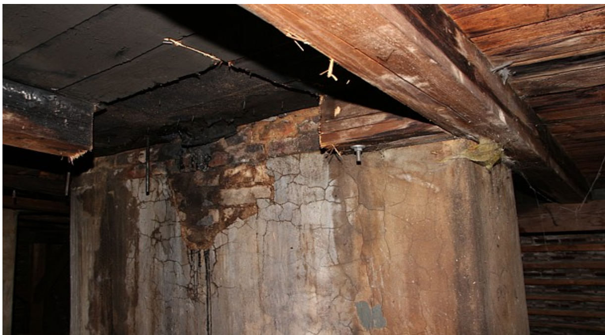
Foto č. 3 Detail poškozeného komínu a vyříznuté konstrukce
