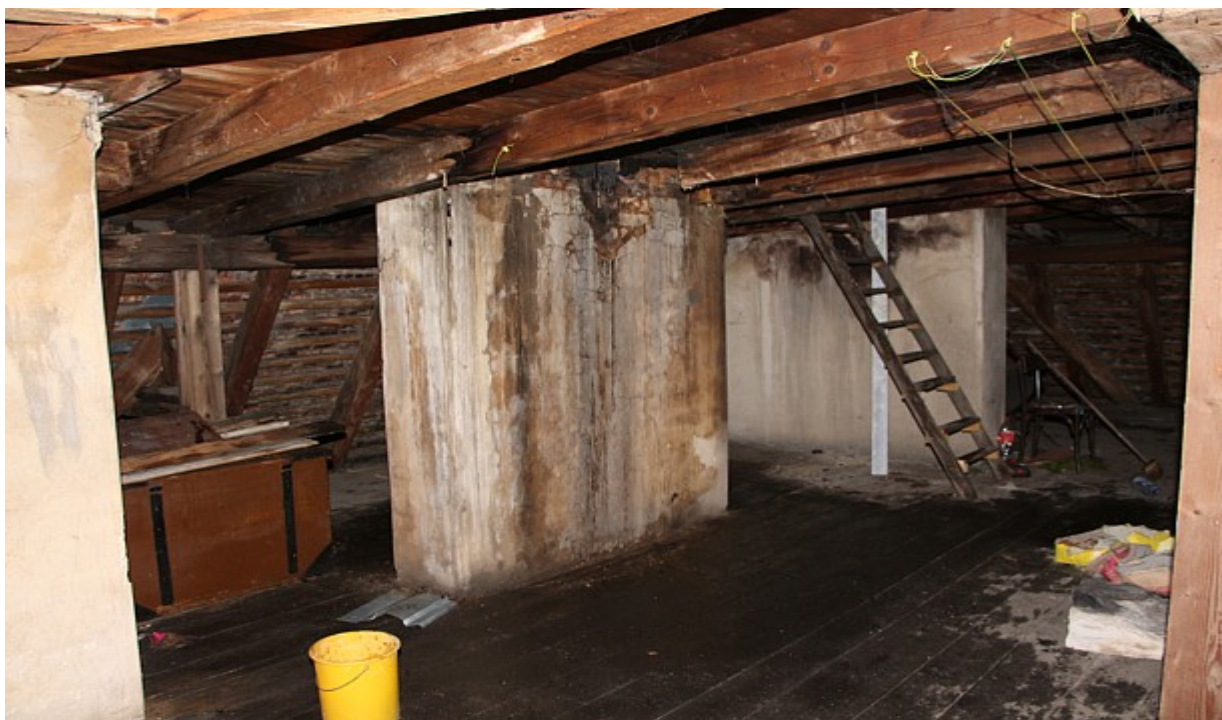
foto č. 1 Pohled na poškozený komín a zasaženou střechu
