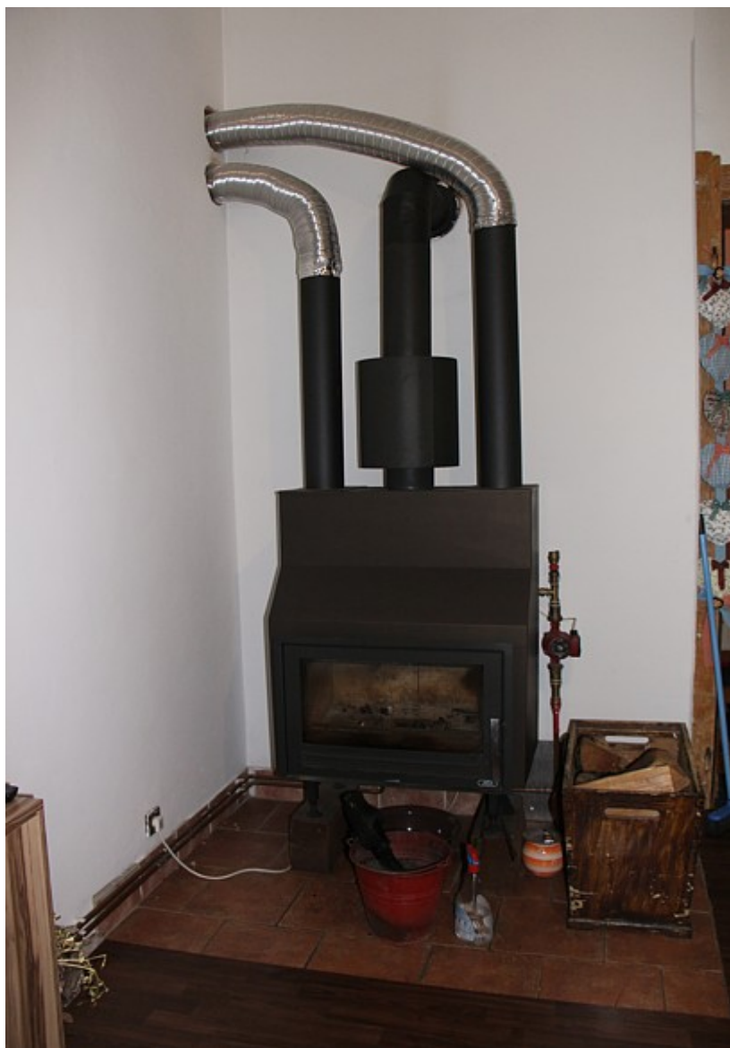
foto č. 2 topidlo, které bylo připojeno na komínové těleso
