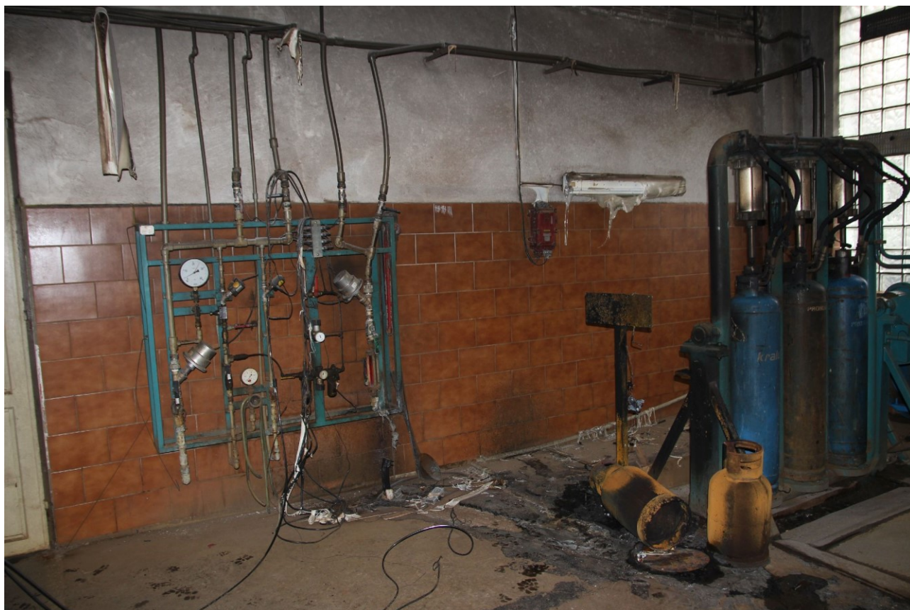
4 Prostor zvaný Výplach lahví – jihovýchodní část, vpusť do kanálku. Toto je jediné místo v požářišti, kde jsou soustředěné známky intenzivního působení požáru na relativně malém půdorysu. Z toho zpracovatel vyjádření usuzuje, že jde o kriminalistické ohnisko požáru /výbuchu
