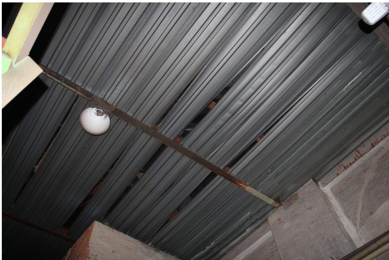
3 Strop z trapézových plechů v prostoru Čištění (za Kovárnou). Plechy jsou volně ložené na nosnících a byly nadzvednuty dynamickými účinky imploze směsi propan-butanu se vzduchem. Touto cestou pronikly hořící plyny do prostoru půdy, kde iniciovaly zviřený prach, a nastal výbuch, který zvedl střechu objektu
