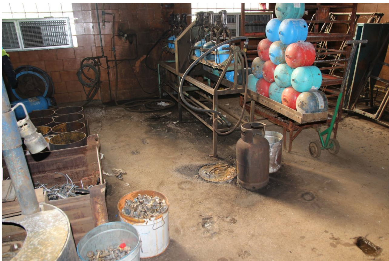
6 Druhá vpust' téhož kanálku se známkami požáru na podlaze kolem a na tlakové lahvi. Vzdálenost mezi vpustěmi 5 m
