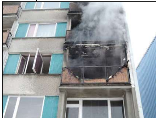
Požár panelového domu Jablonec n. N.
