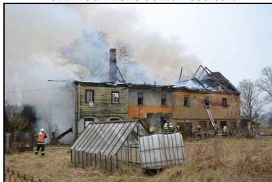
Požár rodinného domu Postřelná
