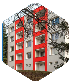
Revitalizace bytového domu Traťová 589/2, Brno
