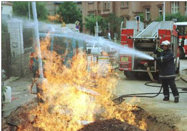
Fotografie č. 3 Požár unikajícího zemního plynu z výkopu
