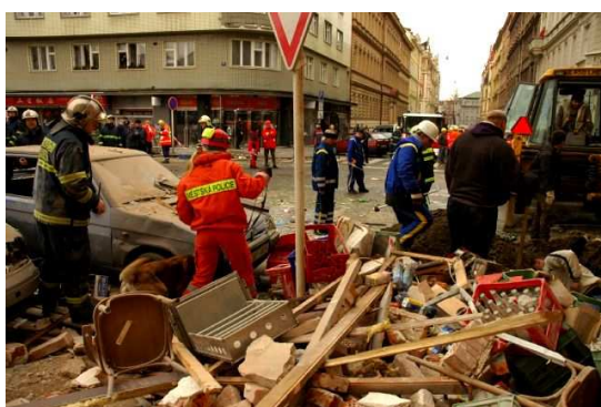
Fotografie č. 8 Pohled namísto kde došlo k výbuchu
