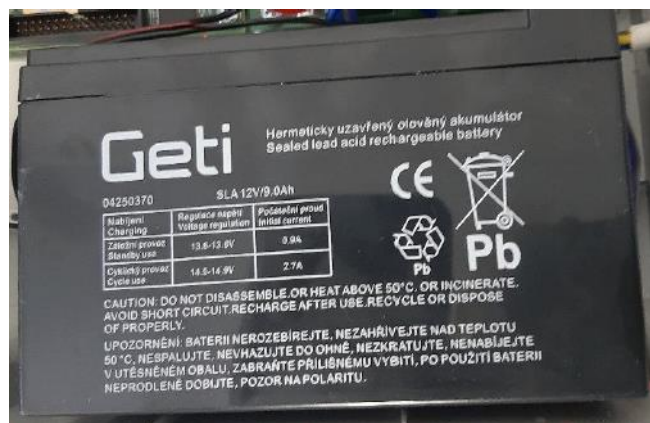
Záložní zdroj hlásiče MIS
