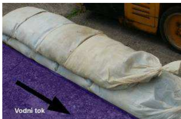
Obr. 6, 7 Způsob kladení jednokomorových pytlů
