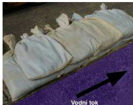
Obr. 5 Způsob kladení jednokomorových pytlů
