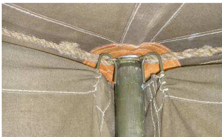
Obr. 31 Detail zavěšení bočních stěn u boční podpěry
