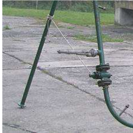
Obr. 52 Detail záslepky s využitím proudnice
