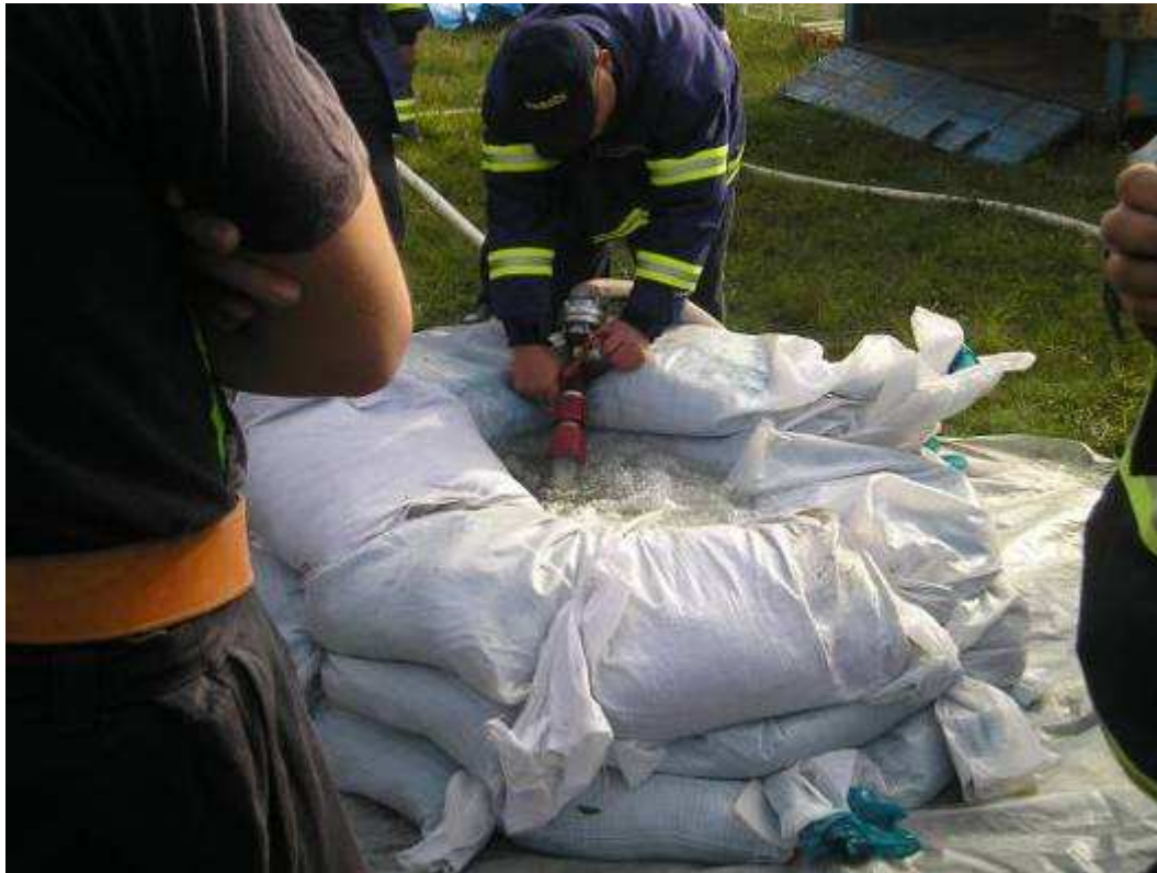
Obr. 5 Stavba protipovodňových hrází
