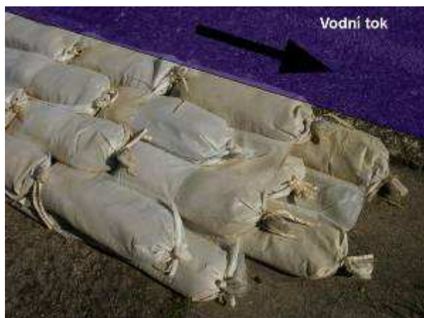
Obr. 15 Způsob kladení dvoukomorových pytlů
