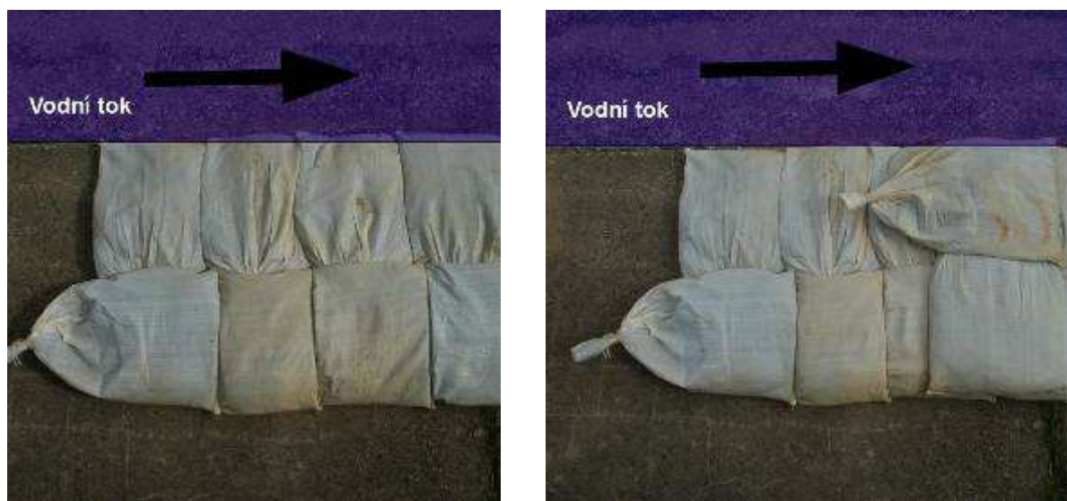
Obr. 8, 9 Kombinované víceřadé kladení jednokomorových pytlů
