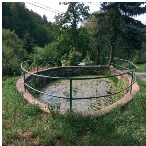
Znečištěná požární nádrž – nepoužitelná
