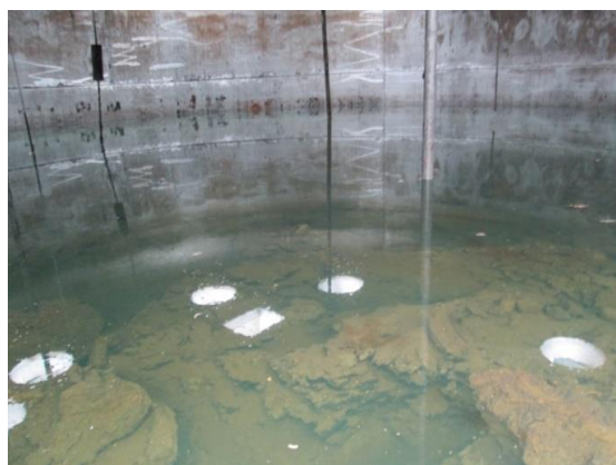
Obr. 2 Tvrdé úsady fosforového kalu na dně zásobníku
