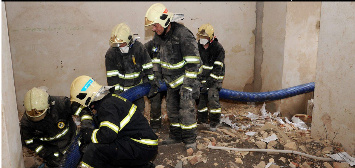
29.4.2013 VÝBUCH PLYNU S MASIVNÍM POŠKOZENÍM OKOLNÍCH BUDOV Praha 1, Divadelní 334/5
