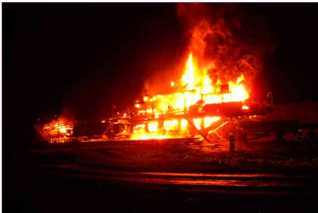
Obr. č. 2 – Poháněcí stanice – rozsah požáru.
