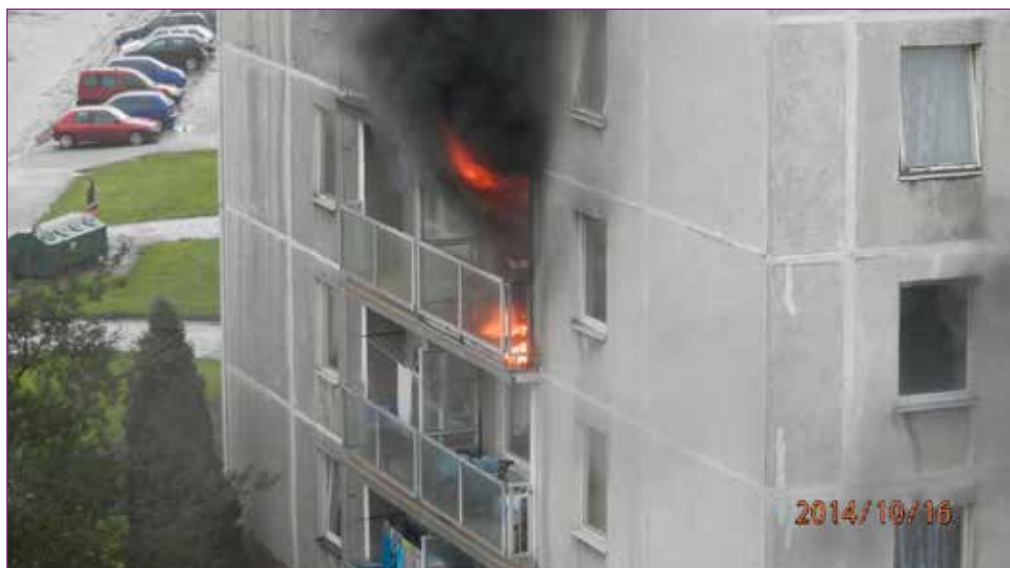
Obr. č. 3 – Požár bytové jednotky před příjezdem JPO.
