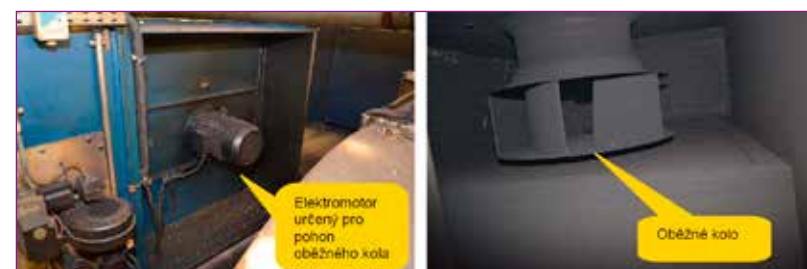
Obr. č. 3 – Oběžné kolo pro odtah kontaminované vzdušiny.
