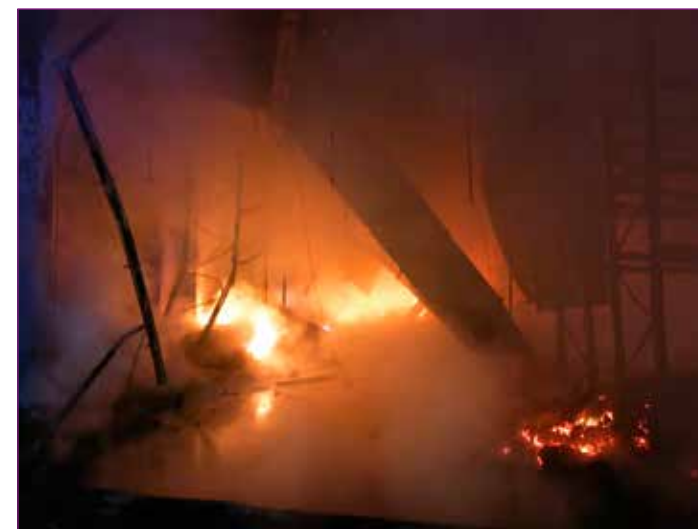
Obr. č. 2 – Expediční hala (požární ohnisko).
