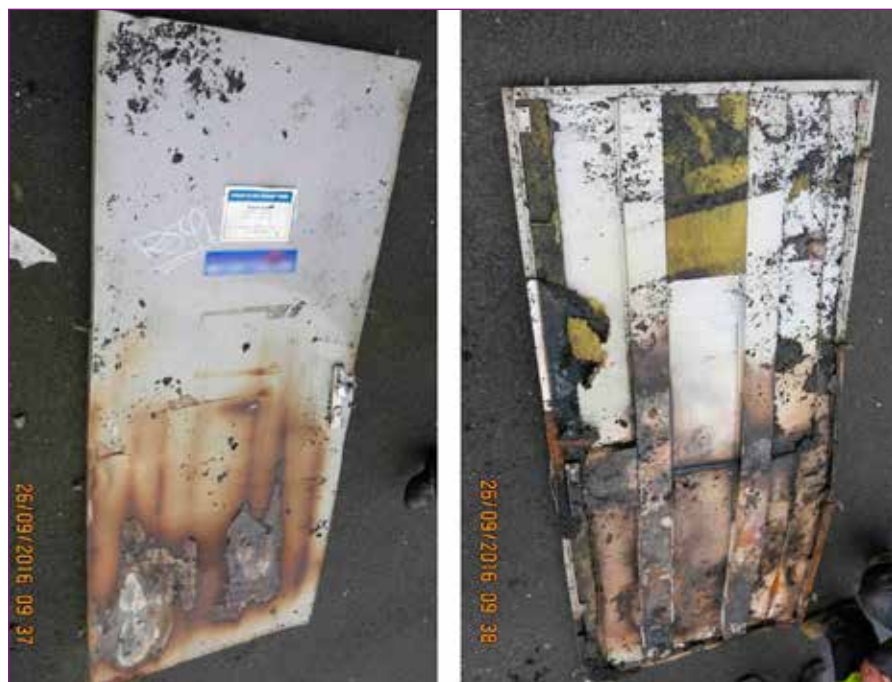
Obr. č. 4 – Patrné vyžhání dveří zevnitř.
