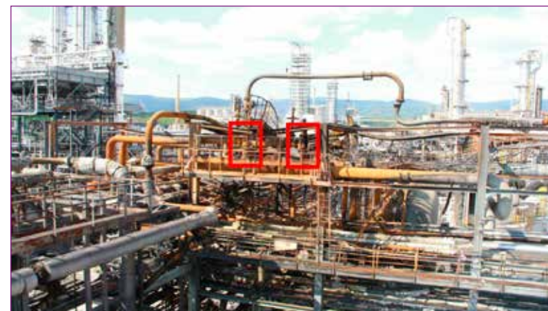
Obr. č. 1 – Požární ohnisko požáru č. 1 – místo uložení pojistných ventilů.
