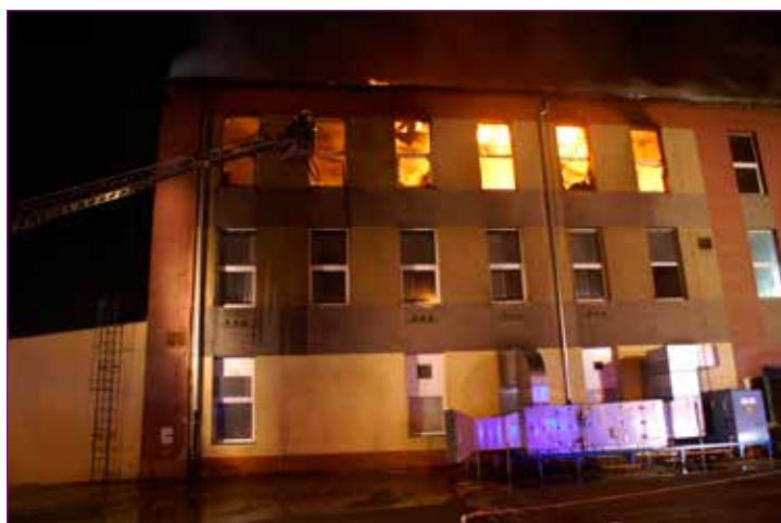
Obr. č. 2 – Východní pohled na objekt v době hasební zásahu.
