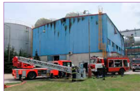
Obr. č. 1 – Hala odvodnění energosádrovce – zásah JPO.
