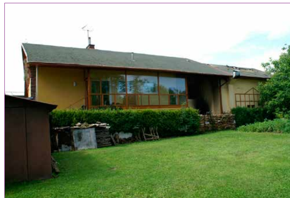
Obr. č. 1 – Pohled na severní stranu zasaženého objektu.
