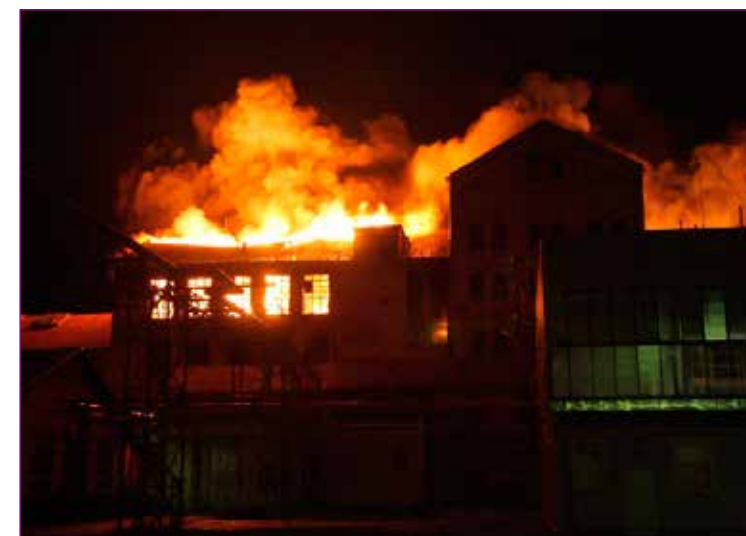
Obr. č. 2 – Objekt při plně rozvinutém požáru.
