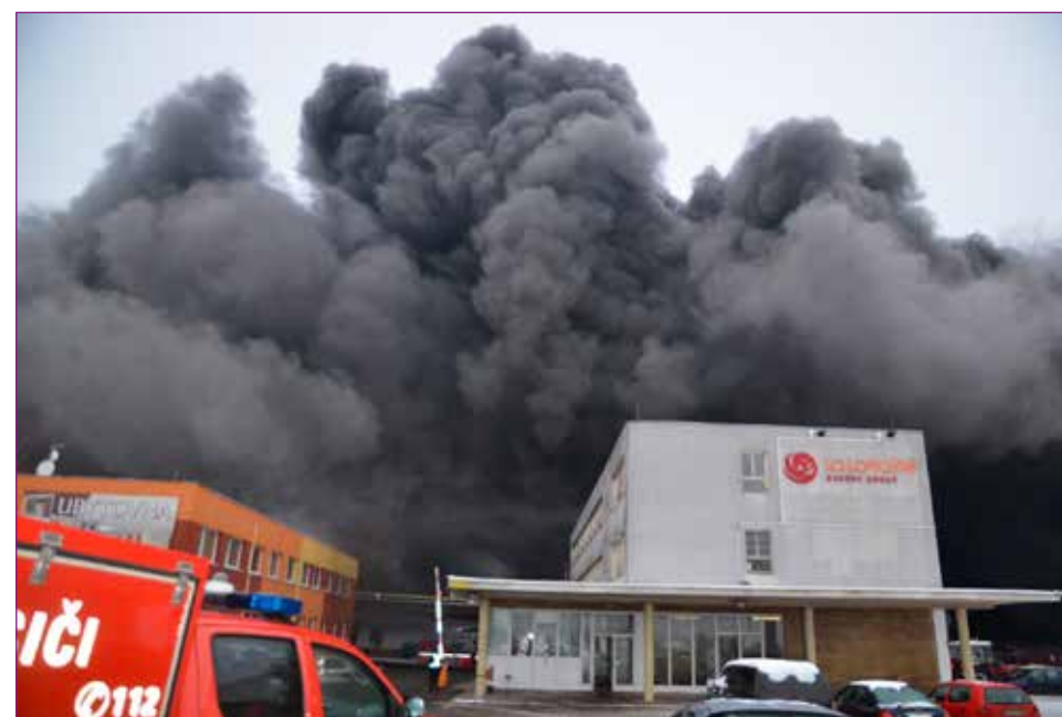
Obr. č. 1 – Celkový pohled na areál v době příjezdu JPO.
