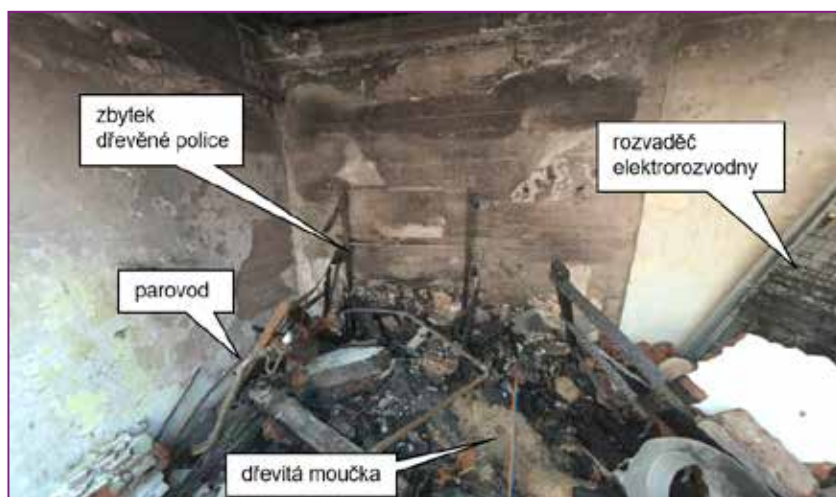
Obr. č. 3 – Pohled do A55/2.
