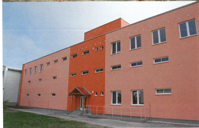
Obr. 5 Budova Národní základny humanitární pomoci před a po rekonstrukci
