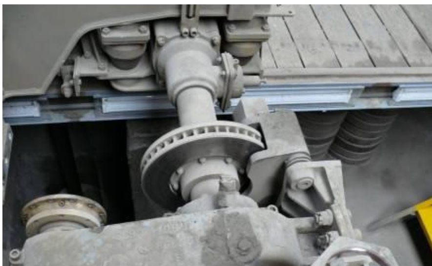
Obr. č. 25 Brzda tramvaje
