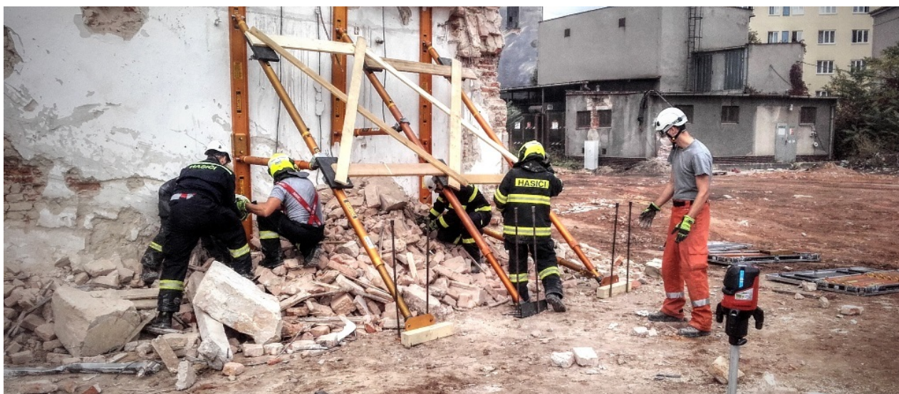
Výcvik specialistů na stabilizaci budov v areálu bourané Vlněny.
