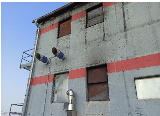
Přetlakové chlazení mezistropního prostoru
