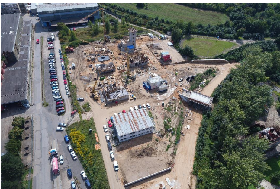
Stavební práce na ŠVZ Brno, ulice Zaoralova
