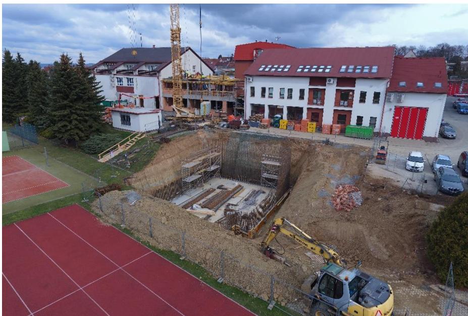
Stavební práce na ŠVZ Brno, ulice Trnkova
